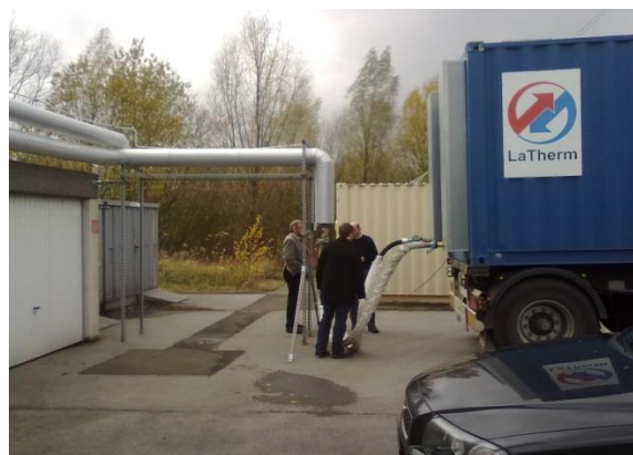
Abbildung 29: Latentwärmespeicher der Firma LaTherm (links: Entladeplatz an der Wärmesenke; rechts: Beladestation an der Abwärmequelle; Quelle: bifa Archiv)
