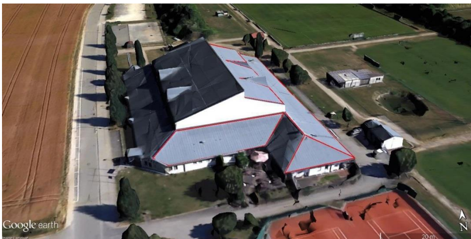
Abbildung 33: 3D-Vermessung der Mehrzweckhalle
