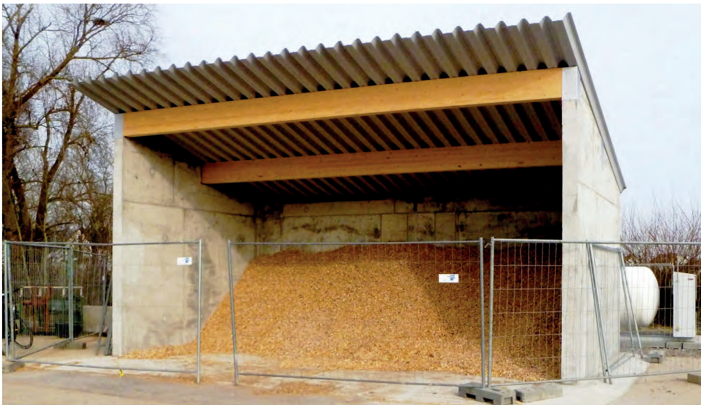
Trockenlager für Hackschnitzel: Die Hackschnitzel werden per LKW angeliefert und hier zum Trocknen gelagert. Foto: Hans-Joachim Graf
