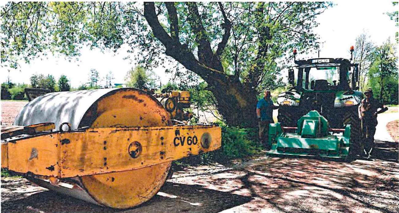
Die Sanierung bzw. das Ausbessern der Feldwege im Gemeindebereich wurde Mitte Mai 2021 abgeschlossen. Die wassergebundene Decke wurde begradigt und erneuert, die Bankette entsprechend bearbeitet. Die Baulast lag bei der Gemeinde. Die Jagdgenossenschaft steuerte 200 Tonnen Schotter bei. Nun haben die landwirtschaftlichen Fahrzeuge wieder „freie Fahrt“, genauso wie Radfahrer und Fußgänger. Foto: Martin Jäger
