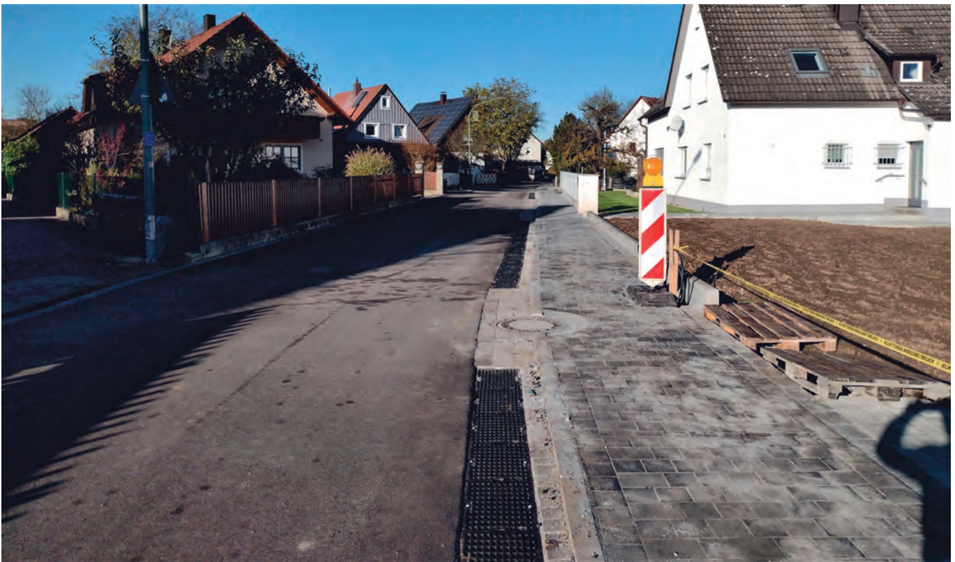
Die Bauarbeiten zur Erneuerung und zum Ausbau des Gehweges bis zur Glückstraße sind voll im Gange. Neu sind auch die Entwässerungsrinnen (Bild Mitte). Foto: Hans-Joachim Graf
