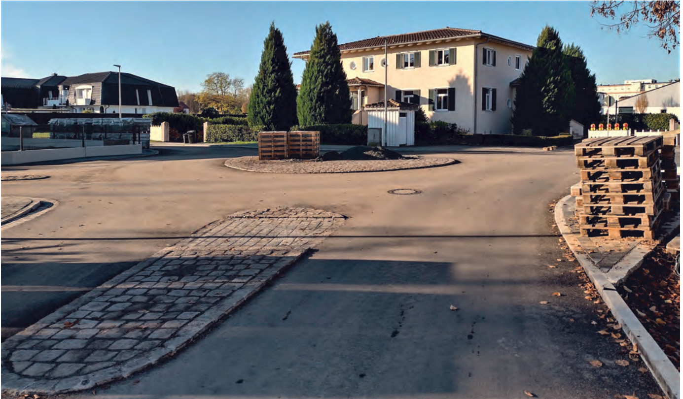
Die Bauarbeiten gingen rasch voran, so dass im Bereich der Hochstraße-Thomastraße-Lutherstraße ein Kreisell und in der Lutherstraße ein Fahrbahnteiler entstanden sind. Foto: Hans-Joachim Graf
