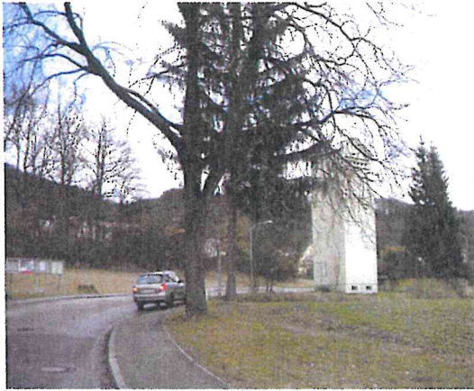
Blick auf den nördlichen Bebauungsrand mit Trafohaus
